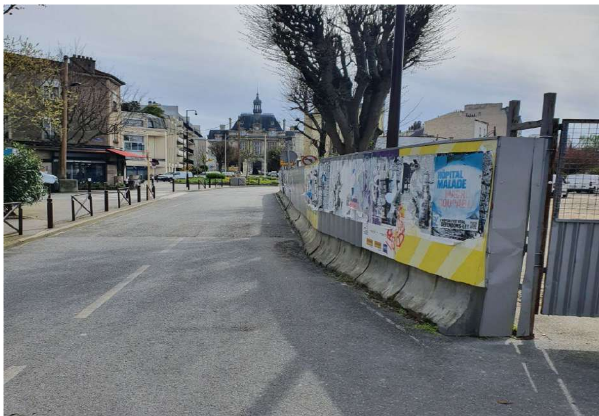
Travaux RATP : Rue du Dr Lacroix
