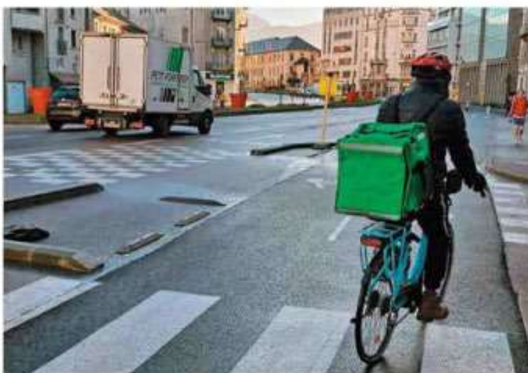
... et après les travaux.
