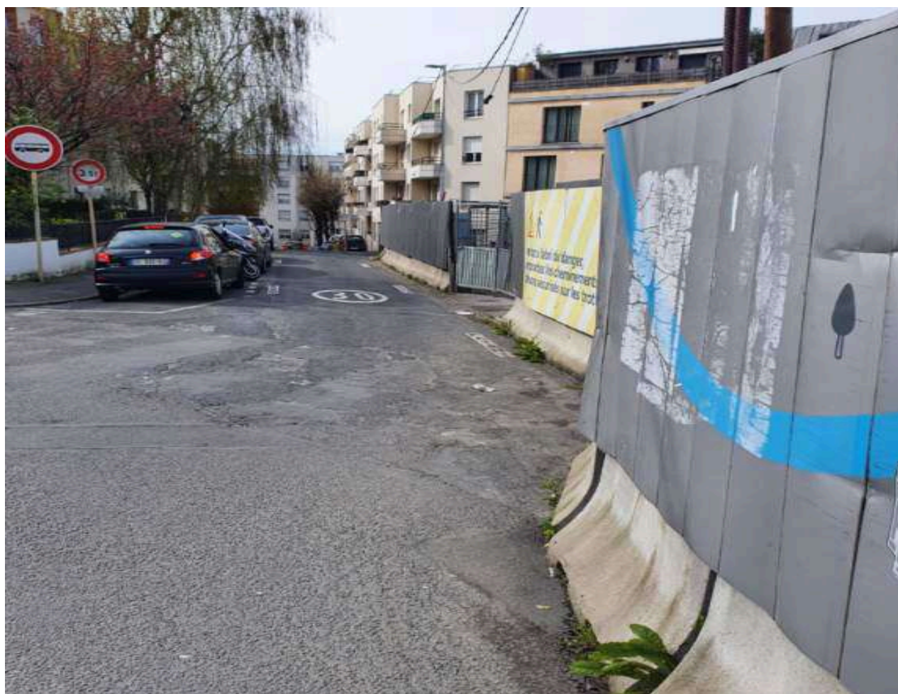
Travaux RATP : Rue Edouard Vaillant
