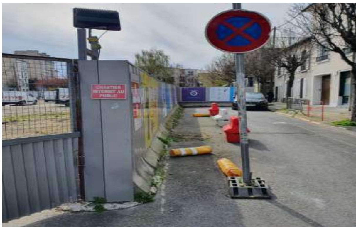
Travaux RATP : Square Jules Guesde
