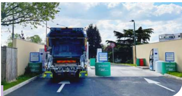
Mise en service de la station bioGNC à Saint-Denis – 17 novembre
