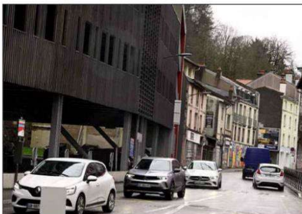
Les bâtiments qui s'élèvent entre le parking Saint-Michel et celui de la carrière Desbuissons vont être démolis pour procéder à l'extension. Photo VM/Eric THIEBAUT
